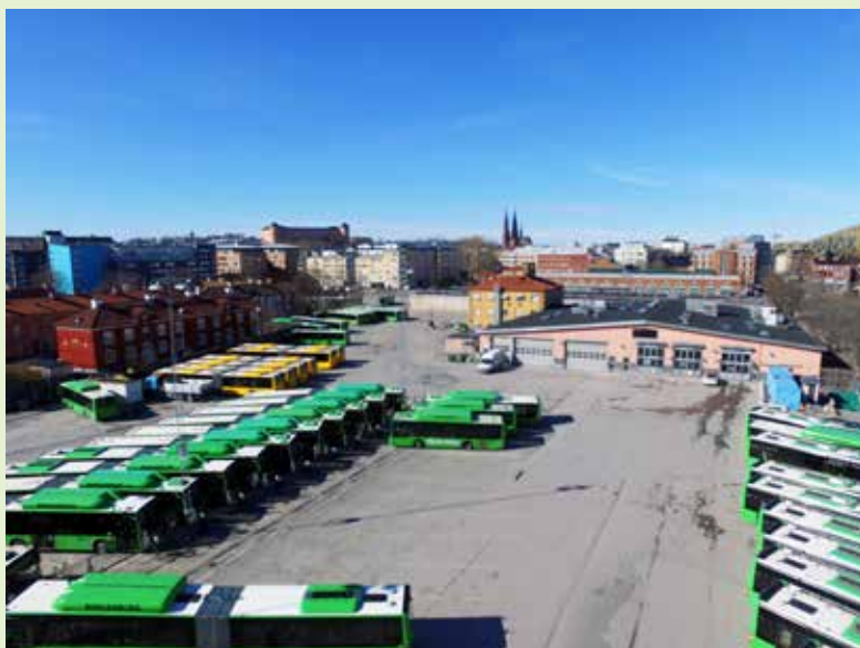
Nuvarande bussdepån med ramper för gastankning och tvätthallen/plåtverkstaden i förgrunden och längre bak i bild garage- och verkstadshallar.
